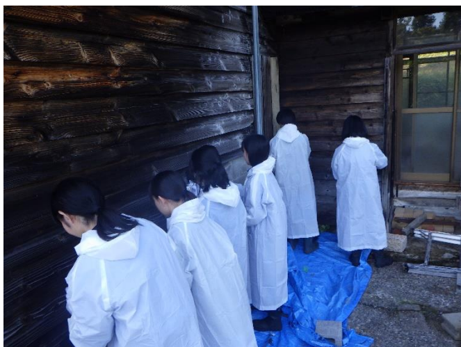
古民家の修繕作業
