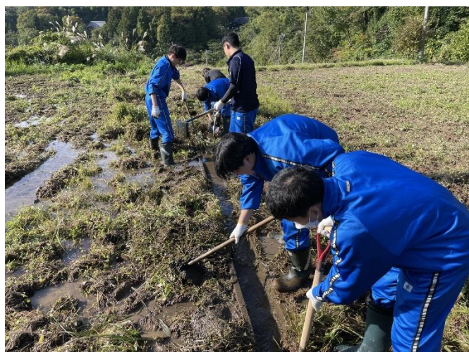
復田のための用水路整備
